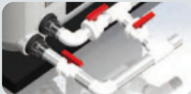
IMAGE 2: Système de dérivation (Bypass)
